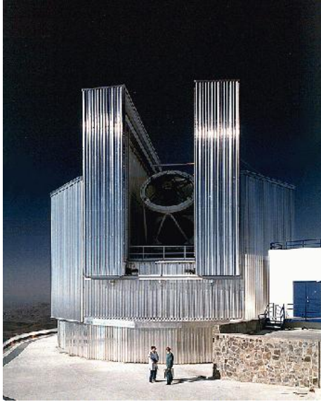
Сл. 1. NTT е сместен на локацијата ла Сила (La Silla). На него е вградена првата во светот активна оптика, што подразбира компјутерска контрола на движењето и фокусирањето на главното огледало.
